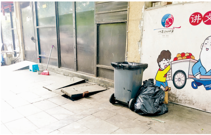
9月12日14点51分,彭山区滨江大道二段2号餐饮店门口垃圾乱放、下水道盖翘起。
