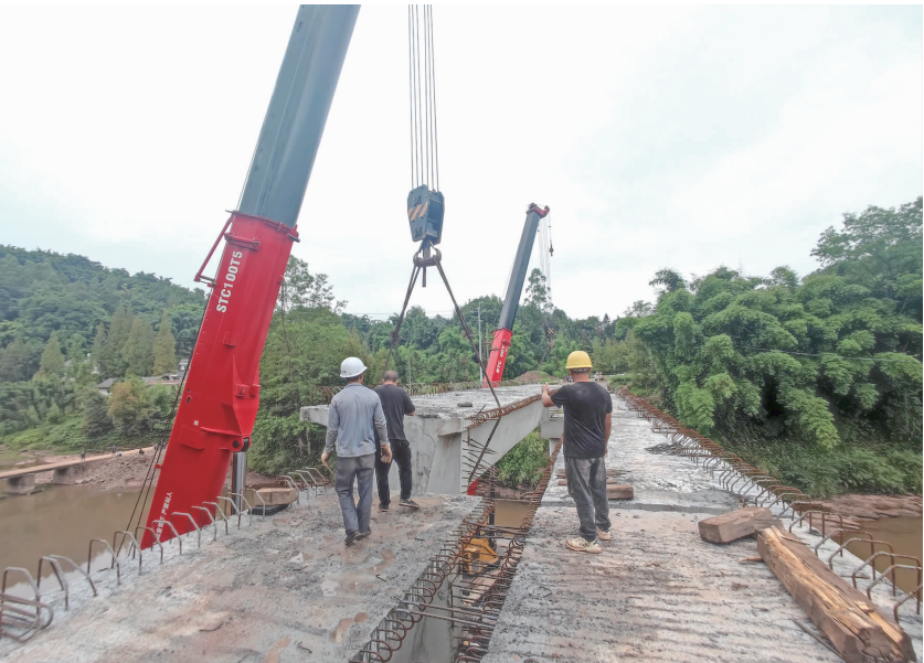
架设最后一块梁板。
