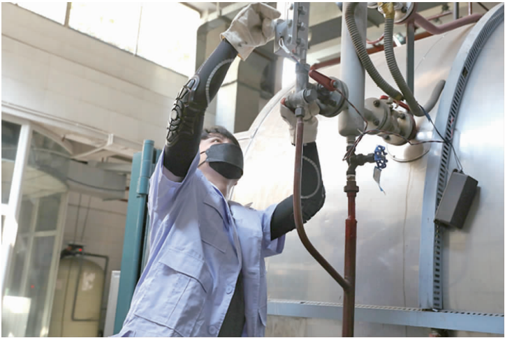
锅炉房,安全检查。
