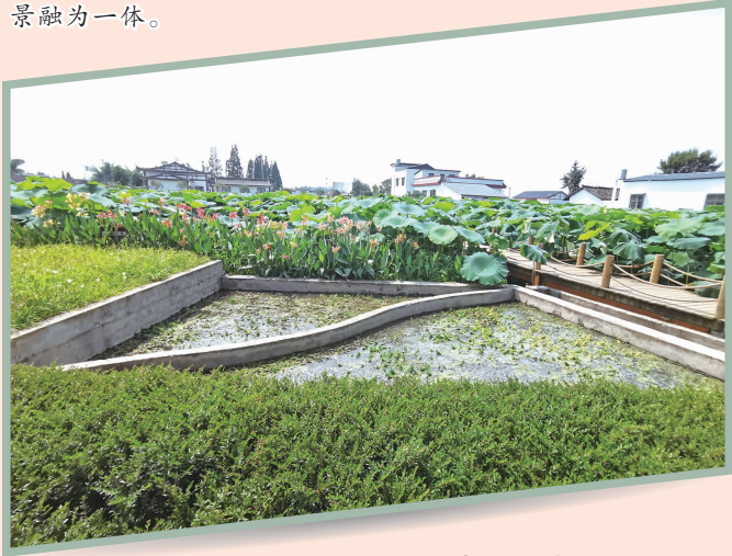
▲永丰村荷塘旁的污水处理池。
