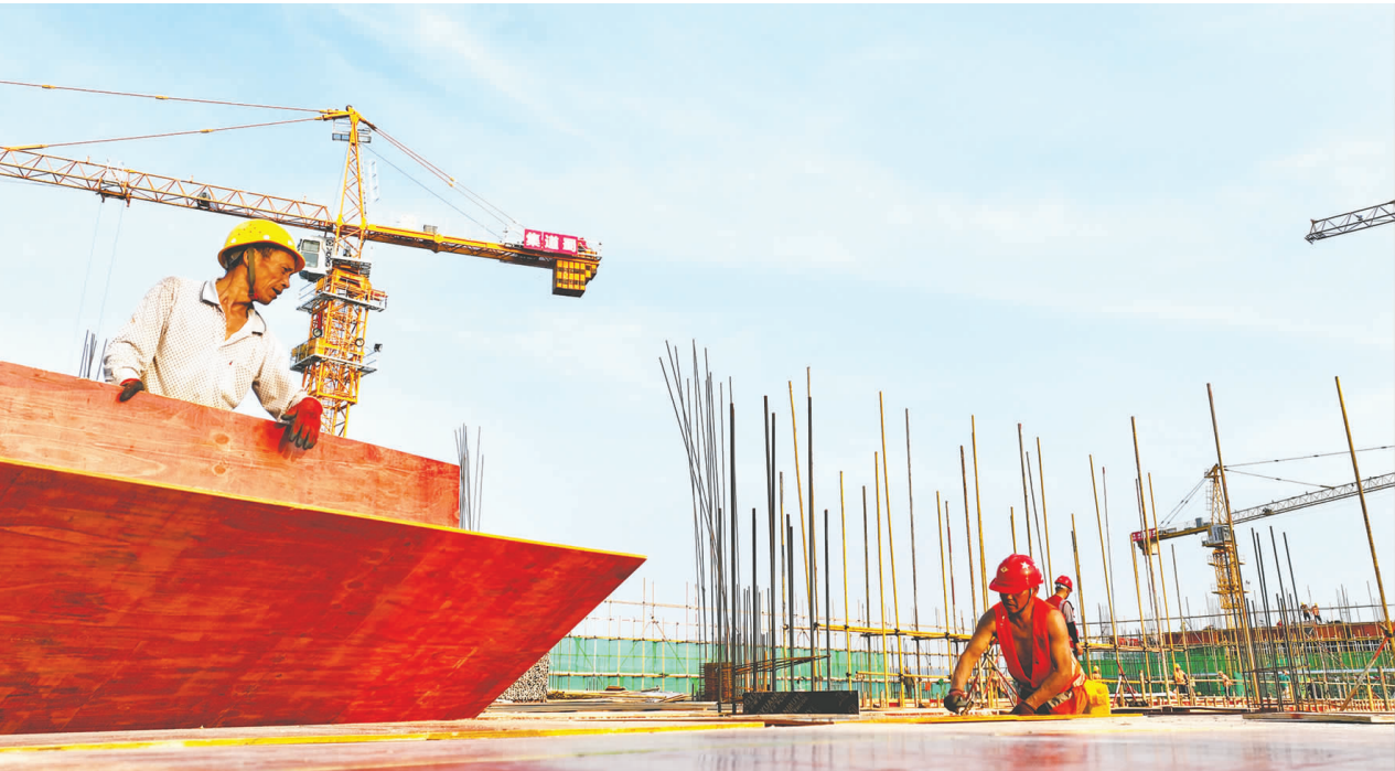
8月17日一早,在四川仁寿经济开发区标准厂房项目建设现场,工人们正在错峰施工。
