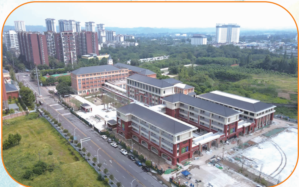
彭山四小扩建项目航拍图。
