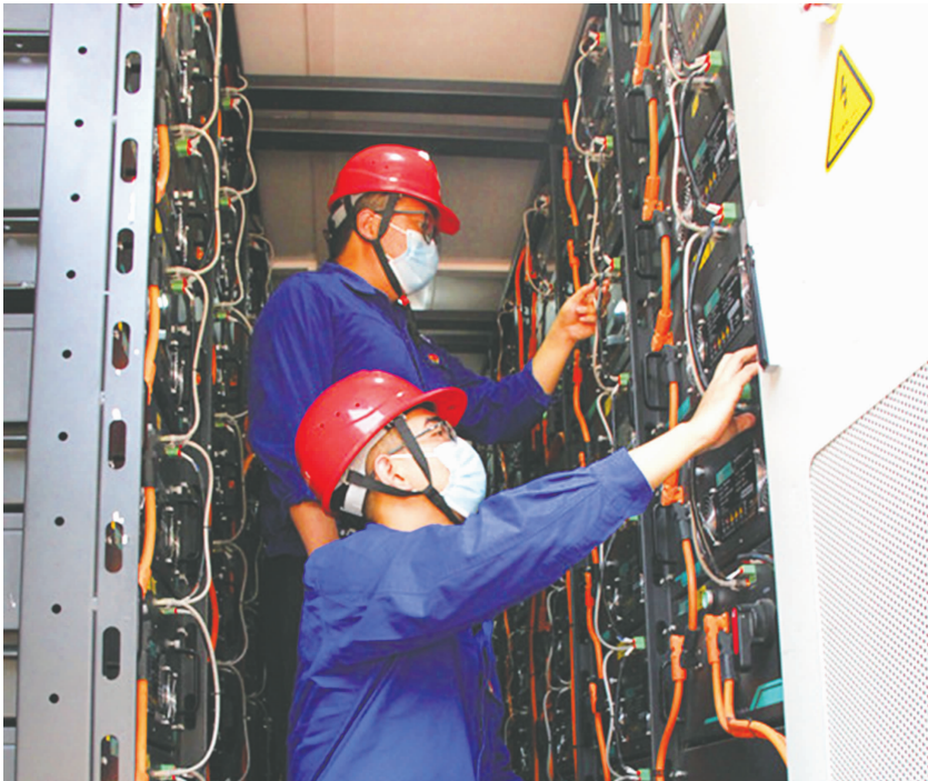
工作人员开展设备调试。胡吉 摄
