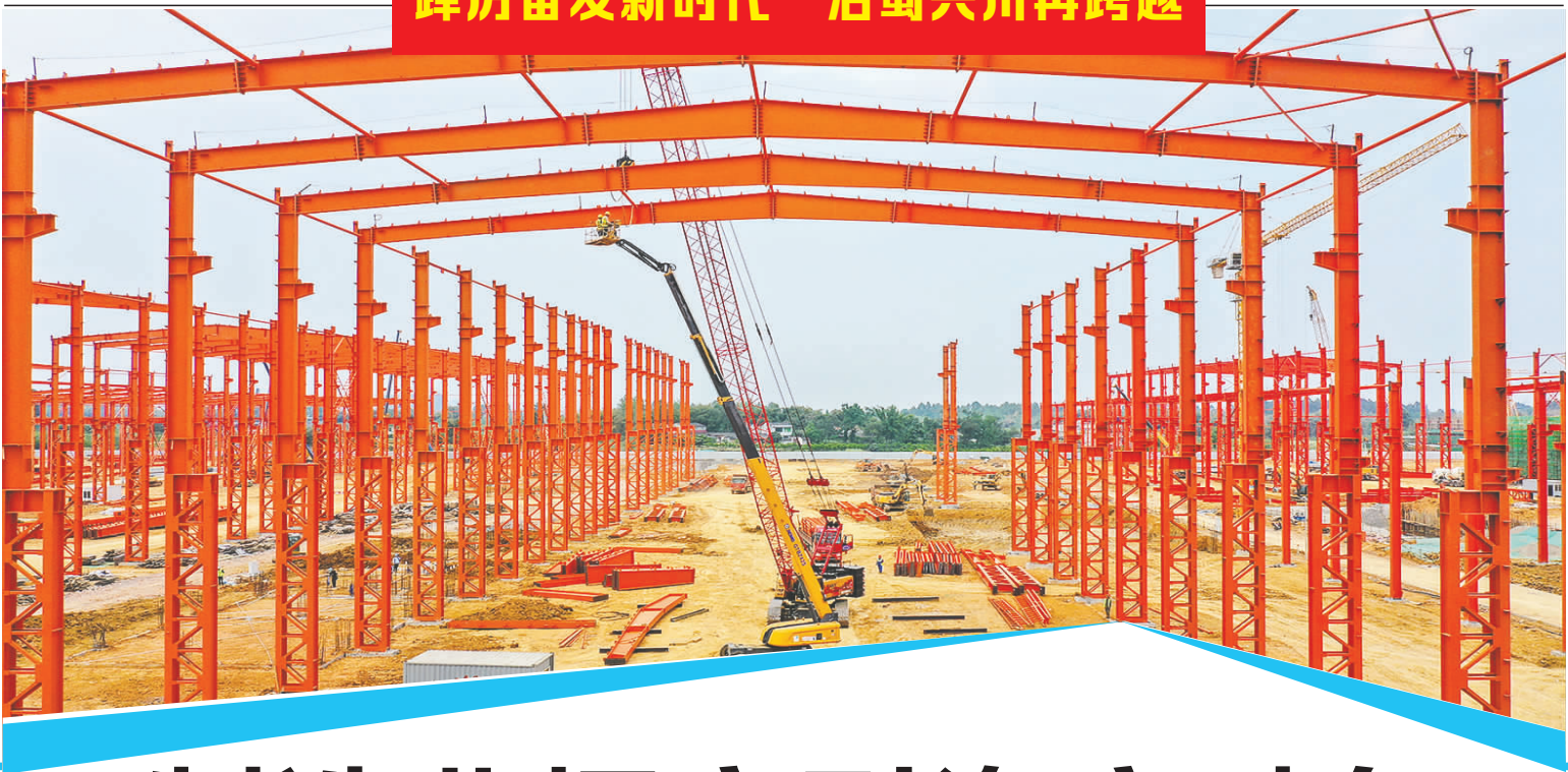
项目建设现场。翁光建 摄
