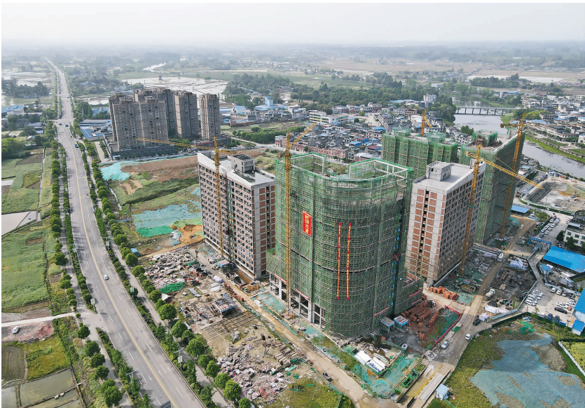
甘眉工业园区城镇综合体一期员工公寓主体已完工。
