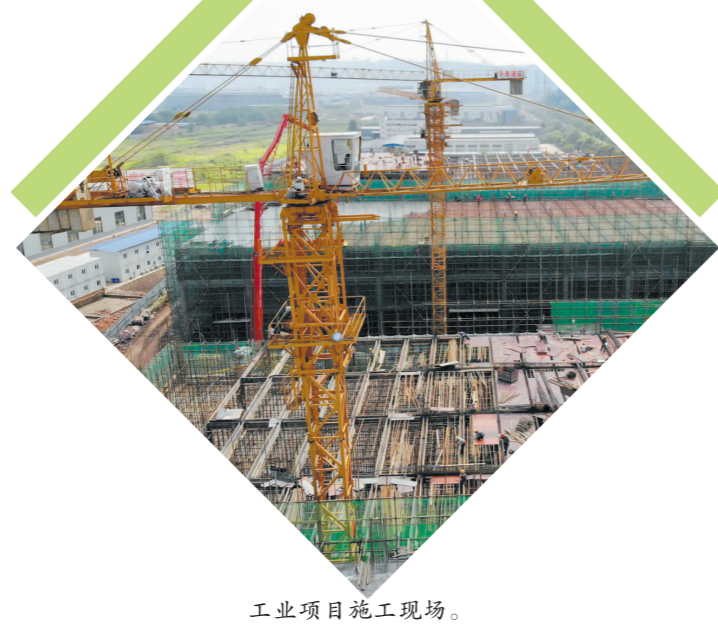
工业项目施工现场。
