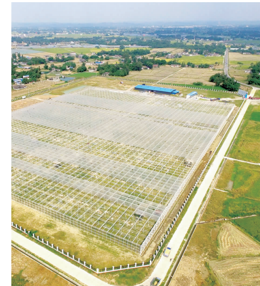
8月20日,记者在岷江现代农业示范园区“西南智慧”农业项目现场见到,项目主体框架已成型,工人们正在进行大棚屋面玻璃的安装。
