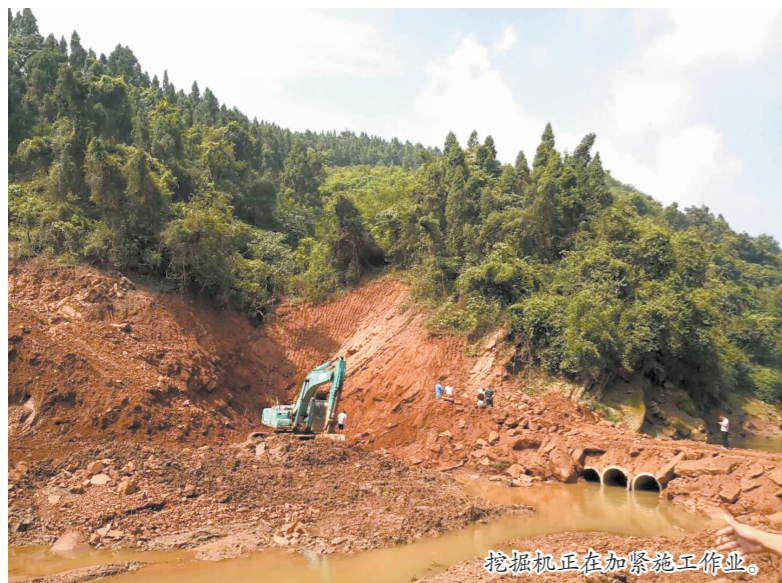
挖掘机正在加紧施工作业。
