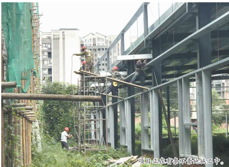
项目正在有条不紊地施工中。
