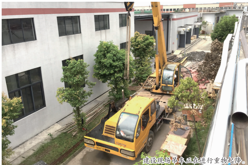
建设现场吊车正在进行重物起降。
