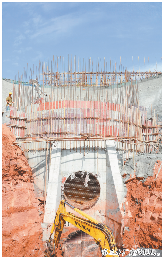
第三水厂建设现场。
