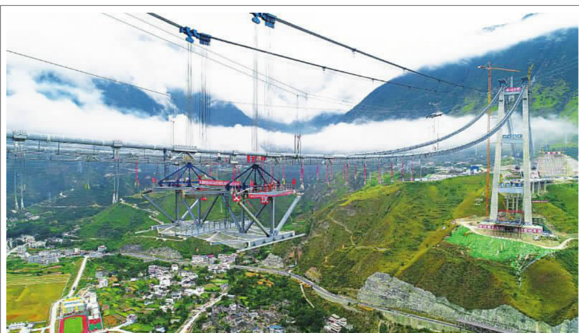
9月26日上午,经过2个多小时的吊装,雅康高速泸定大渡河兴康特大桥首段钢桁梁成功就位。
