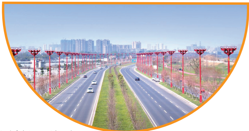
滨江大道建成投运，眉彭公交开通。
