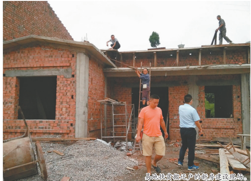
易地扶贫搬迁户的新房建设现场。
