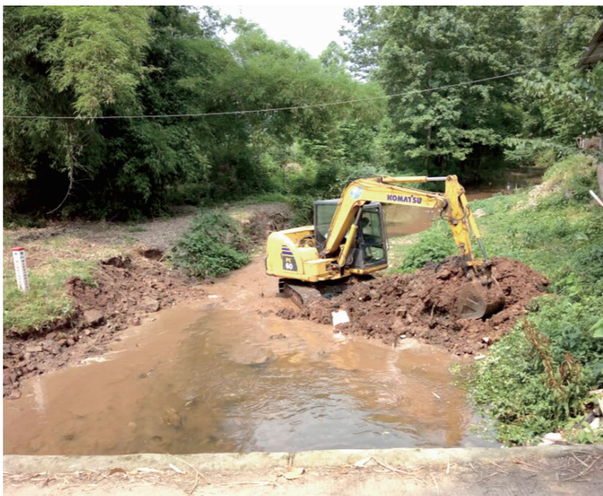
河道清障,畅通河道。
