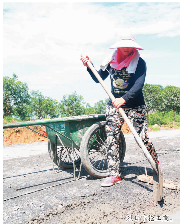
铺筑道路水稳层。
