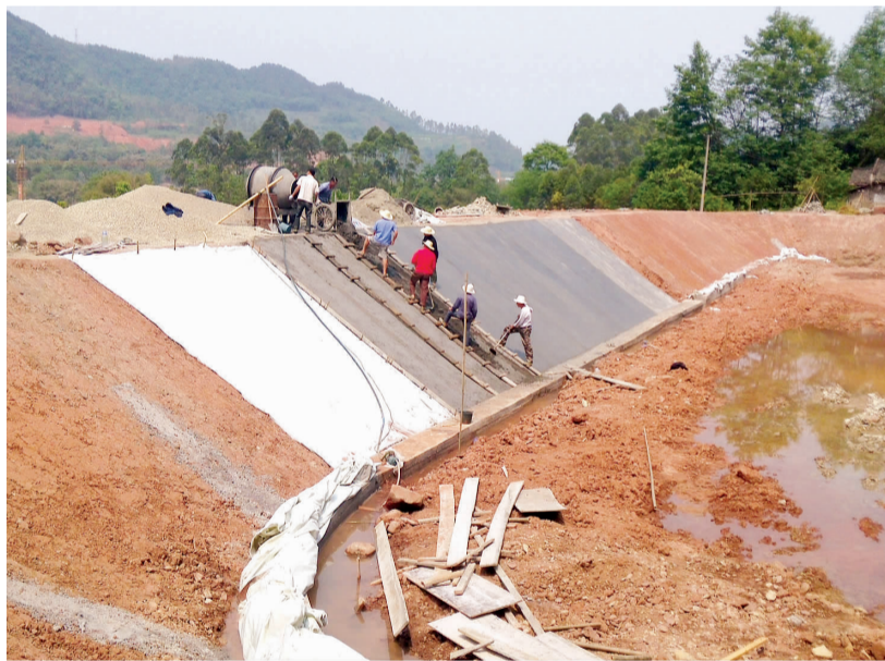
山坪塘防渗施工现场。
