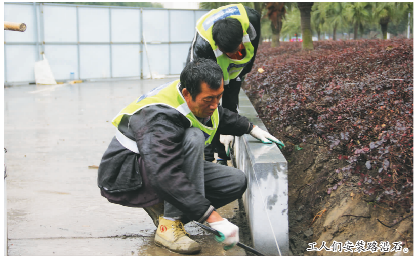
工人们安装路沿石。
