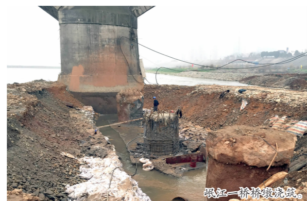
岷江一桥桥墩浇筑。
