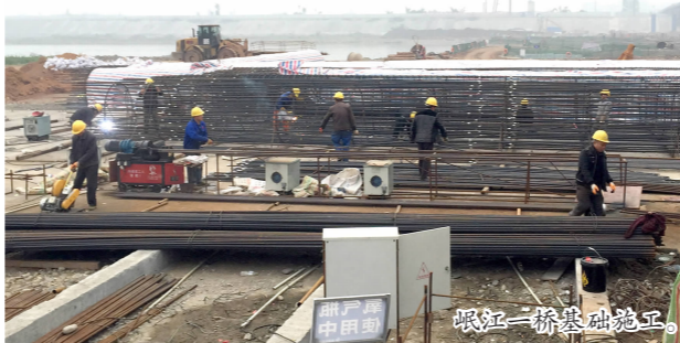
岷江一桥基础施工。
