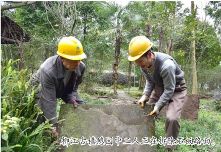
柳江古镇组团中工人正在拆除石板路面。
