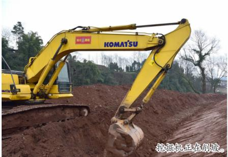
挖掘机正在削坡。
