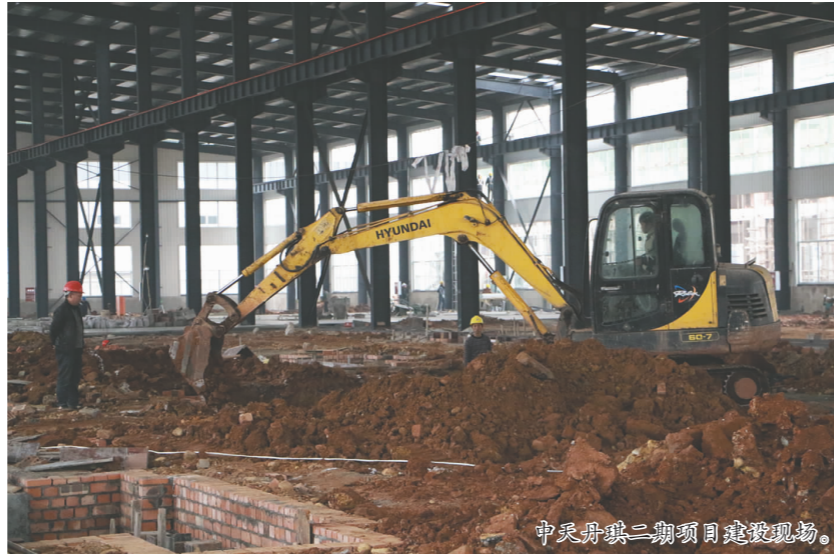
中天丹琪二期项目建设现场。
