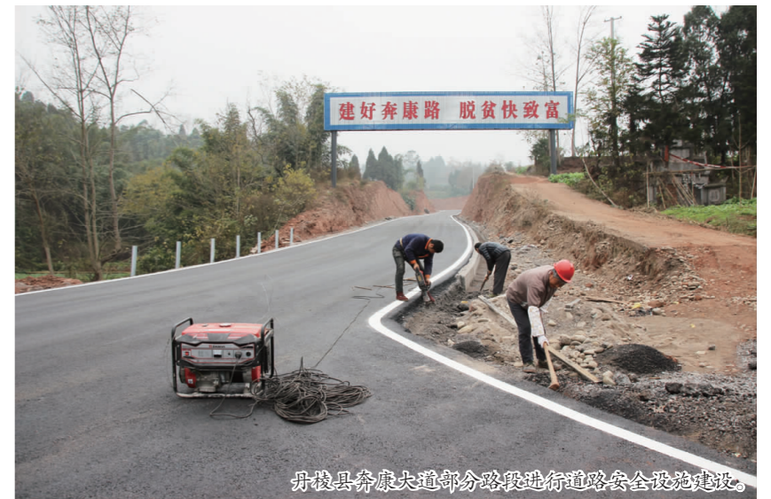
丹棱县奔康大道部分路段进行道路安全设施建设。
