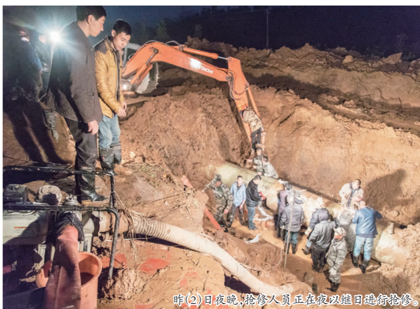
昨(2)日夜晚,抢修人员正在夜以继日地进行抢修。
