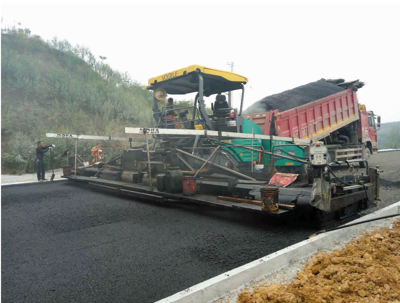
岷东大道彭山段建设现场。
