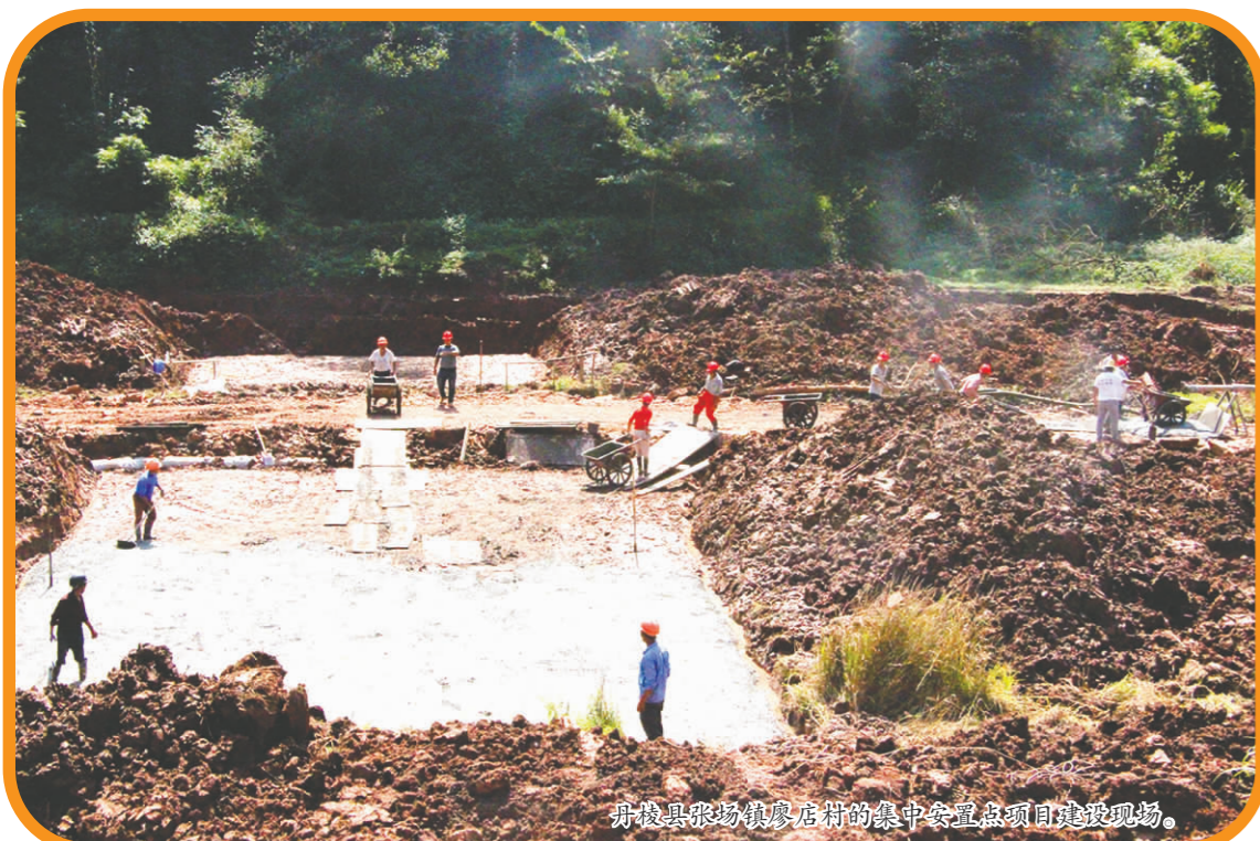
丹棱县张场镇廖店村集中安置点项目工地现场。
