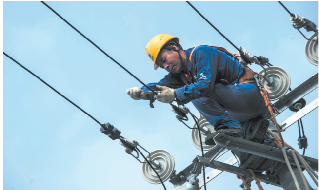
电力工人正在高温下抢修。
