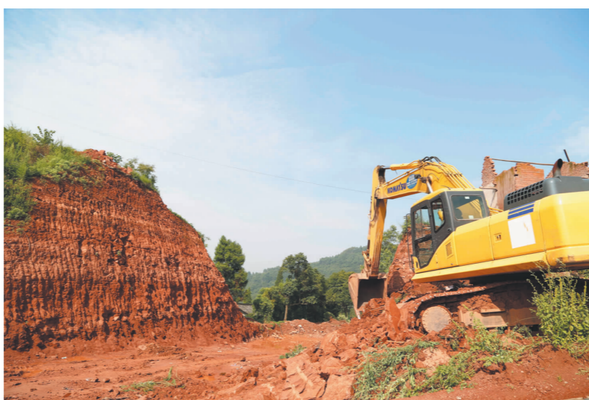
奔康大道万年段正在抓紧施工。
