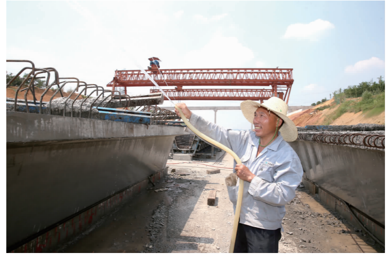
岷东大道铜车河大桥建设现场,工人正在给混凝土预制件降温。
