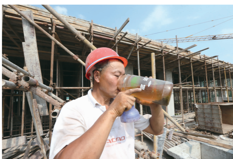
东坡区白虎滩安置小区建设工地上,工人正在补充水分。
