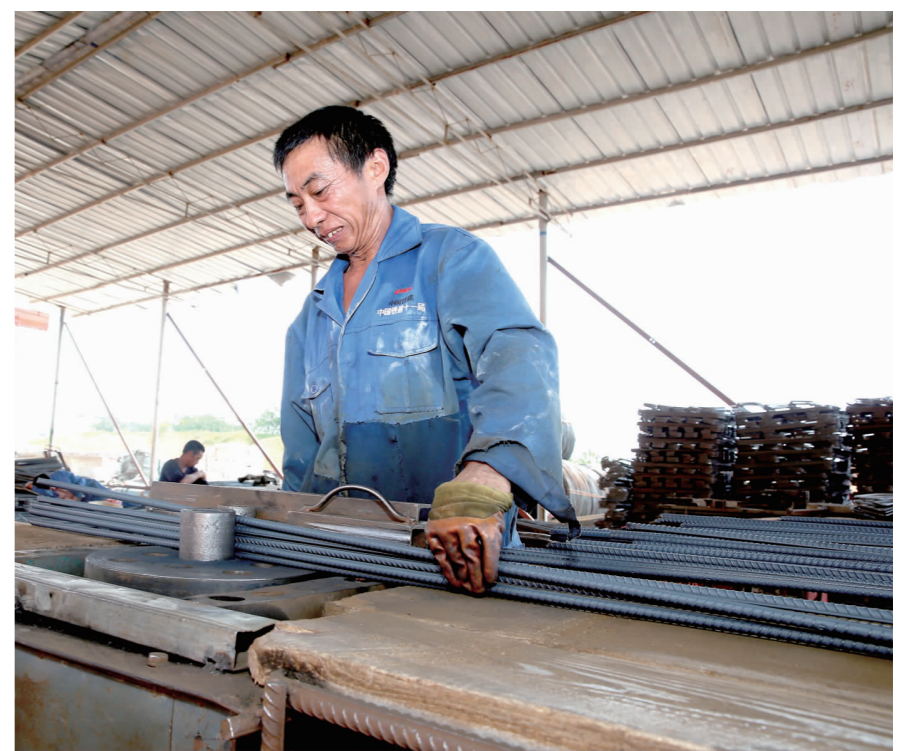
岷东大道建设现场,工人正在制作钢筋件。
