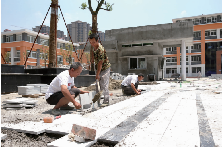
苏辙小学建设现场。
