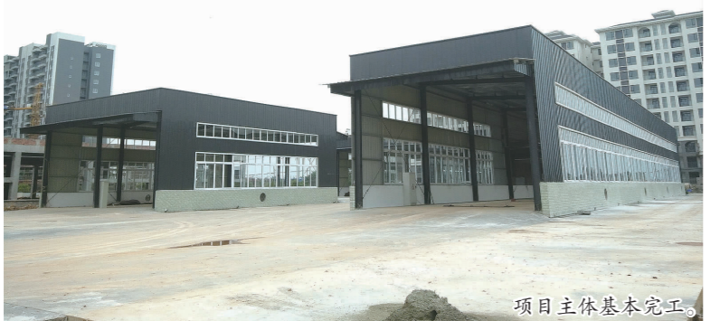
项目主体基本完工。
