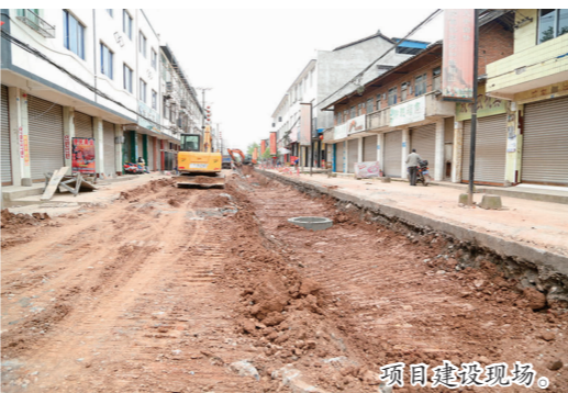
项目建设现场。
