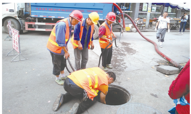
为进一步增强城市汛期排涝功能，预防雨季“水漫街头”的现象出现，近日，洪雅县市政设施维护管理
