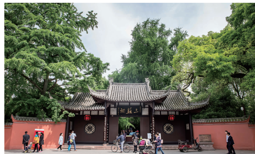
经过两年多的震后闭馆抢救性维修,三苏祠开门迎客。
