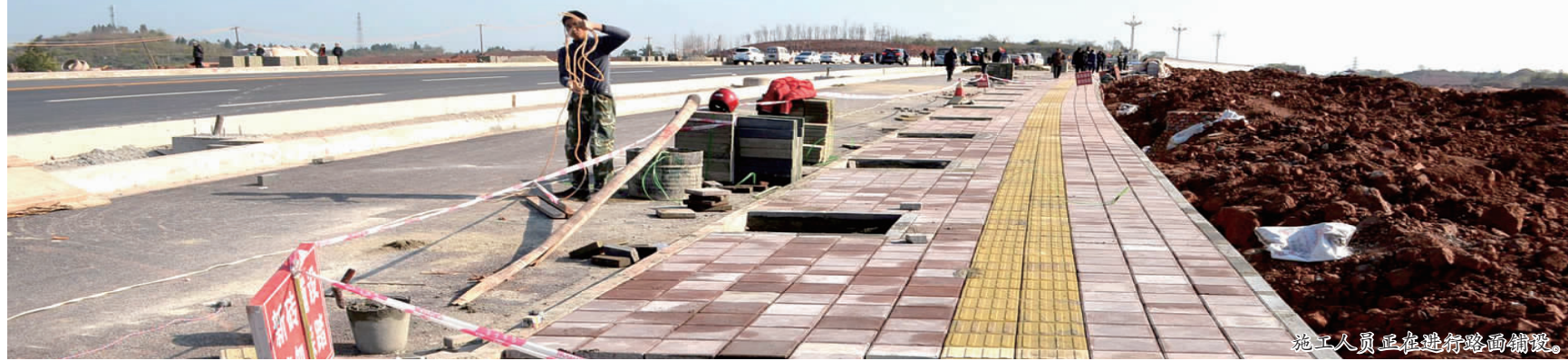
施工人员在铺设路面。
