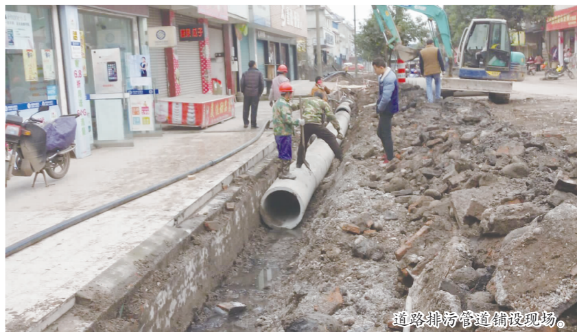
道路排特管道铺设现场。
