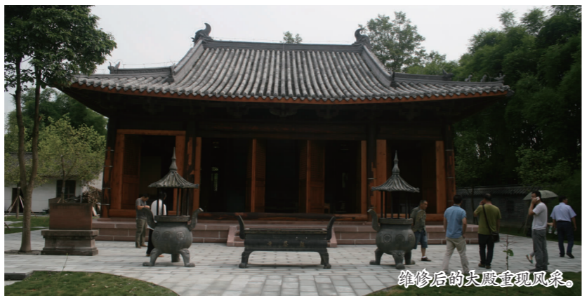
维修后的大殿重现风采。
