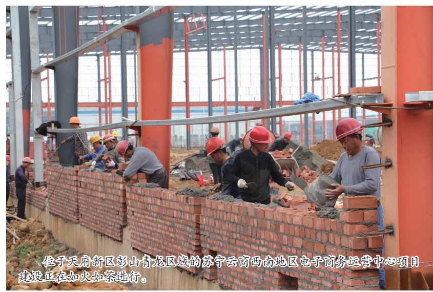
位于天府新区彭山青龙区域的苏宁云商西南地区电子商务运营中心项目建设正在如火如荼地进行。
