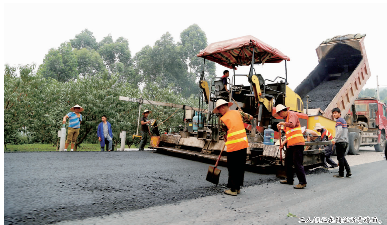
工人们正在铺装沥青路面。
