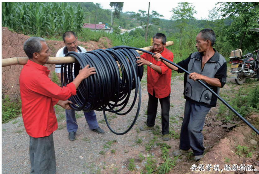
安装管道,辐射村组。
